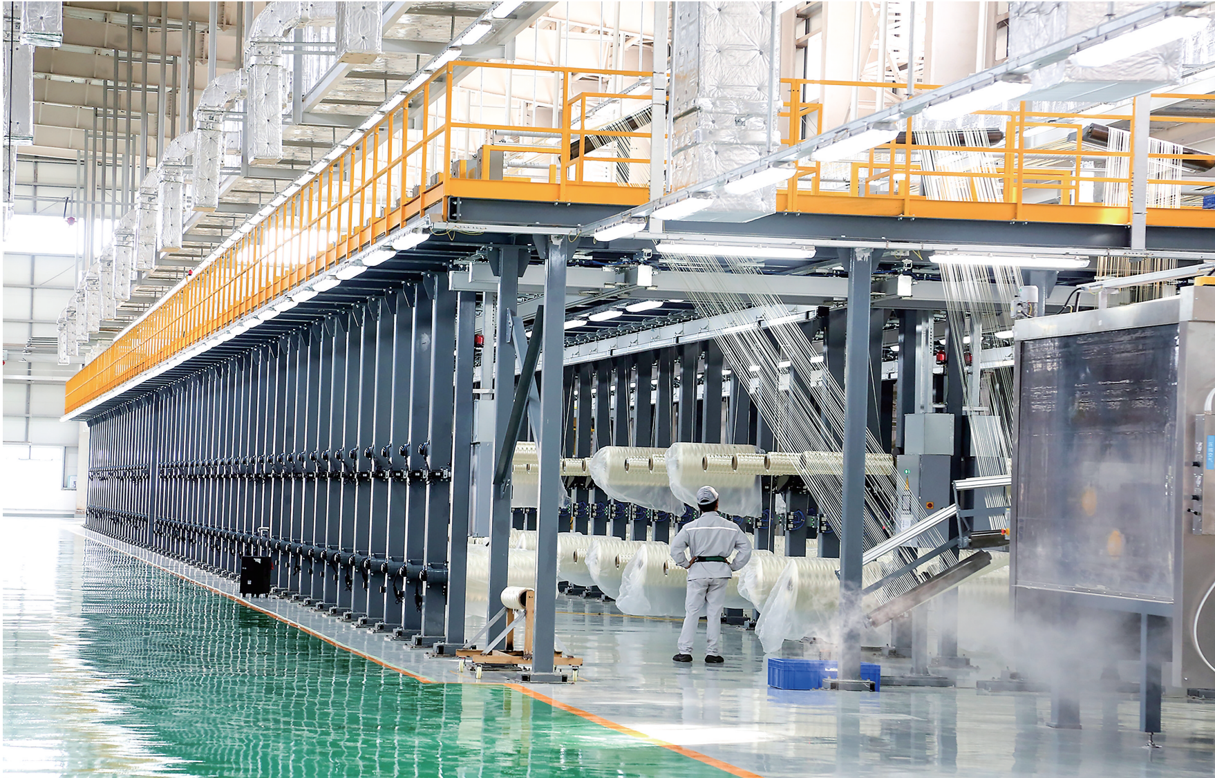
东华能源—茂名万吨级碳纤维项目生产车间
