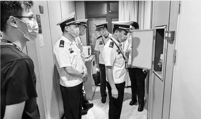
消防人员开展消防安全专项夜查,检查场所消防设施。
