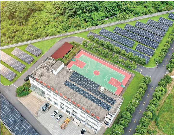
茂名滨海新区分布式光伏首期项目。
