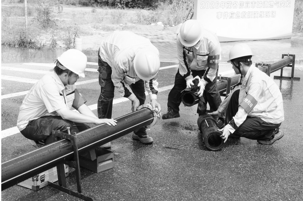
工程技术人员对破损天然气管道进行抢修。
