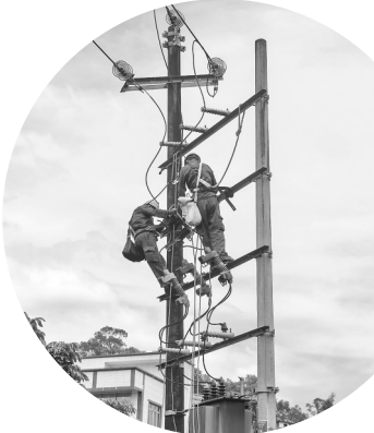
高州供电局科学制定网架升级改造实施方案,顺利完成10千伏煤矿线黄塘岭矿支线网架完善工程收官作业。通讯员 陆贵立 摄
