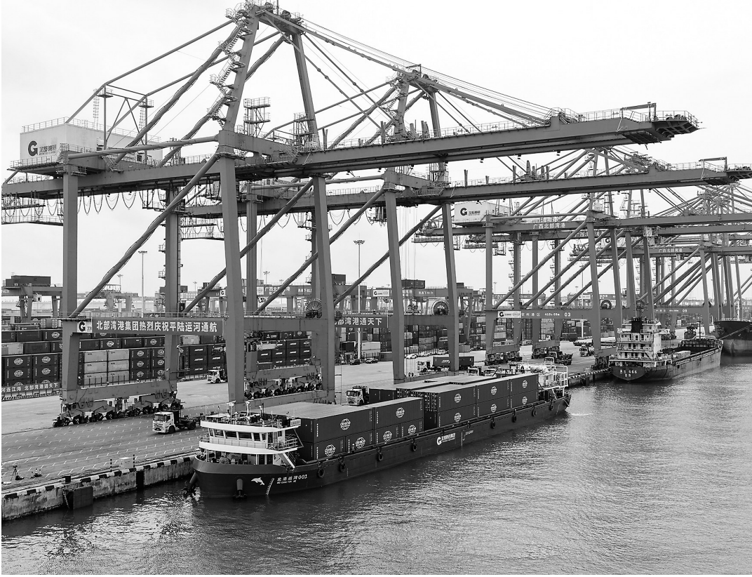
这是9月16日在广西钦州市拍摄的北部湾港钦州港区。9月16日,新中国成立以来第一条国家层面统筹建设的通江达海运河工程——平陆运河建成通航,开辟西南出海新通道。新华社记者 张爱林 摄
