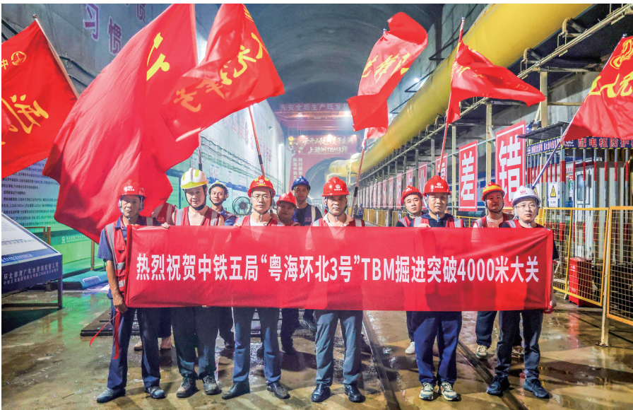
中铁五局环北广东工程“粤海环北3号”TBM掘进突破4000米。记者 甘杨松 通讯员 王中天 陈可瀚 摄
