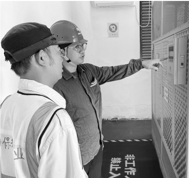
工作人员深入重点用户场所开展用电安全排查,消除线路隐患,筑牢节日保电防线。
