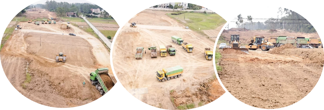
图为施工现场。
