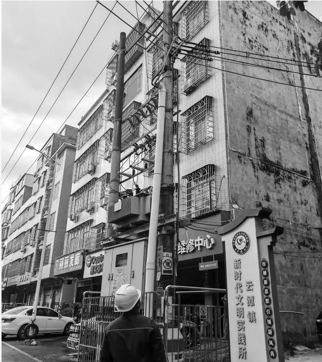
茂名高州供电局组织供电所开展低压台区专项自主排查整治行动。
